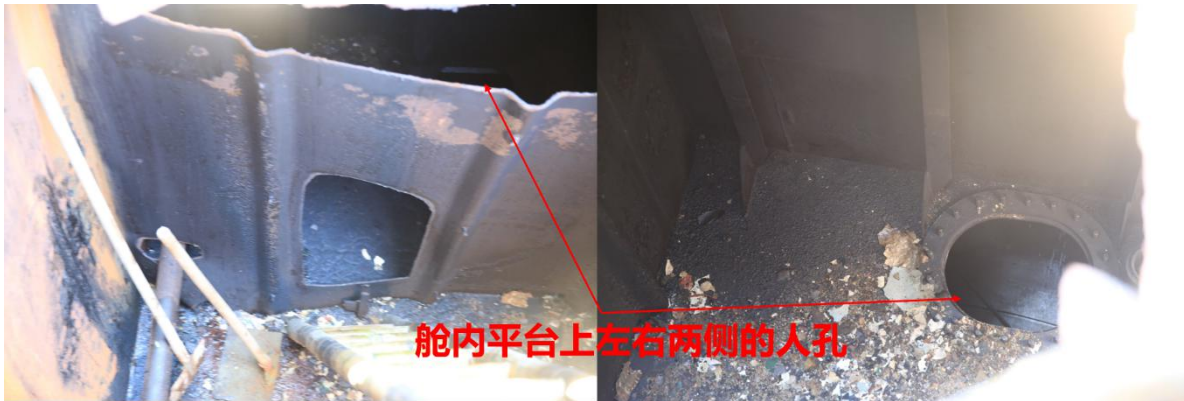
图 8: No.1 重油舱（左）通过舱内平台的人孔与下部舱室贯通
